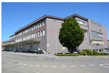
Usine de production d'Almeva en Suisse
